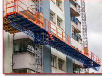
Bina Dışı İskele Grupları (Building non-scaffold group)
